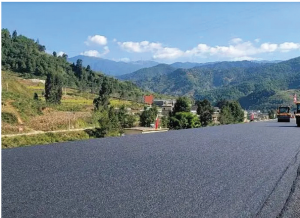
图 1 现场铺筑试验段
