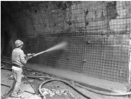
图 2 混凝土喷射浇筑
