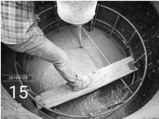
图 4 混凝土现场振捣
