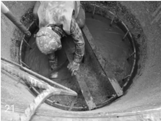
图 5 混凝土抹面处理
