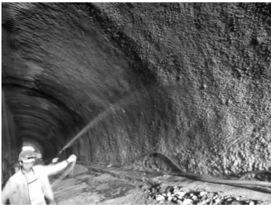
图 3 混凝土洒水养护
